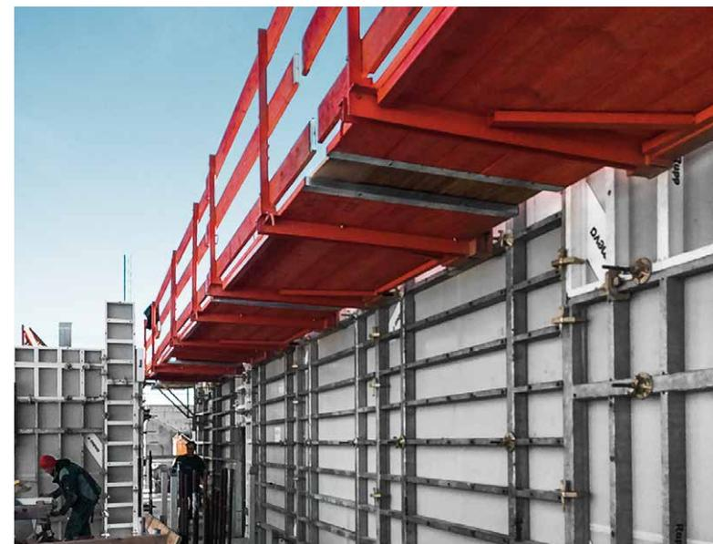
Simple segura y rápida. La plataforma simplemente se engancha en el encofrado.
