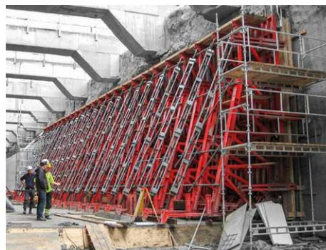
Apuntalamiento de muros a una sola cara hasta 13,50 m de altura.
